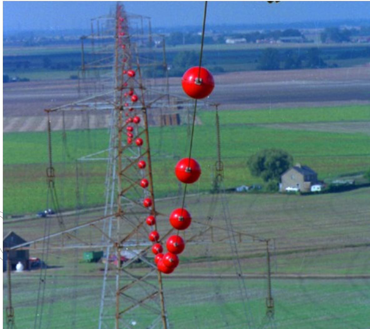
Foto de Esferas de Balizaje como puntos de referencia y alarma visual para aeronaves
