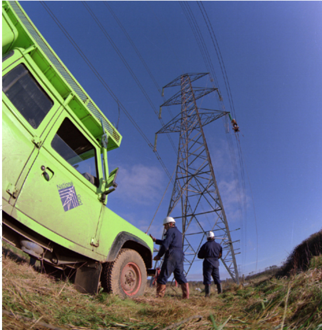
Vista general de Trabajos en una línea de transmisión de doble circuito
